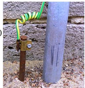
Sí, amigxs, así de sencillo es crear una toma de tierra si no tenemos. Basta con clavar una estaca metálica a la que conecte el cable de tierra.
