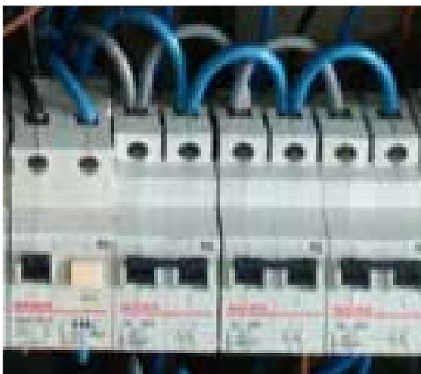
En la fotografía se aprecia el diferencial a la izquierda, de él salen por debajo una fase y un neutro que pasando por detrás suben hasta el primer magnetotérmico y desde ahí se hace puente por arriba al resto de magnetotérmicos (siempre fase con fase y neutro con neutro, **cuidado de no cruzar ningún polo**) quedando la zona inferior de los mismos libre completamente para usarlas como salidas.
